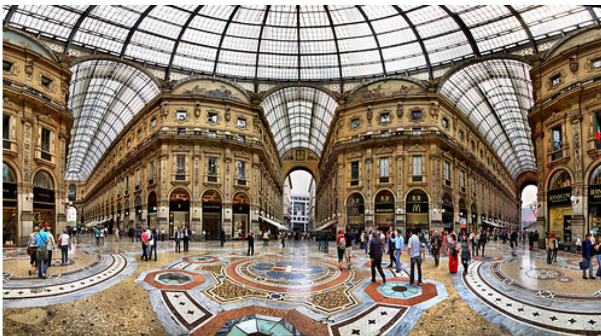
Fig. 10. La Galleria Vittorio Emanuele II di Milano 9
